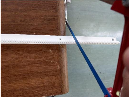
標準同梱されるレール500mm×2本を組み合わせて施工します。1000mm以下の幅の引き戸では、ドア幅にあわせレール端を切断します。レールはアルミ材と糸ノコで簡単に切断可能です。
